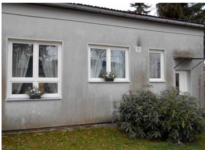
Kompletní výměna oken v mateřské škole
