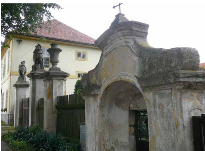
Ohradní zeď s kapličkou před rekonstrukcí
