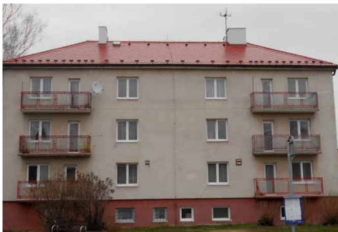
Rekonstruovaná střecha na zdravotním středisku
