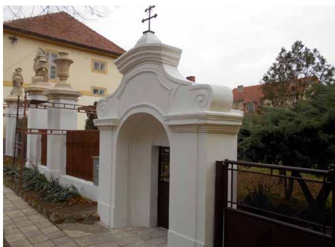
Ohradní zeď s kapličkou po rekonstrukci
